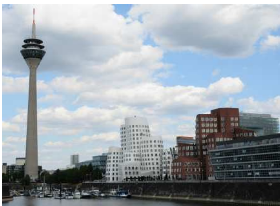
ライントワーと再開発されたハーフェン地区
